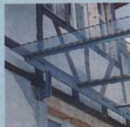
Die Konstruktion besteht aus handelsüblichen Eisenprofilen
