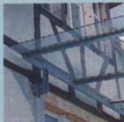
Die Konstruktion besteht aus handelsüblichen Eisenprofilen
