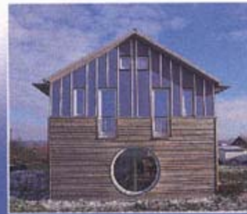
Für das Passivhaus mußten die Fenster supergut sein: Dreifachverglasung mit extrem aufgedoppelten Rahmen, K-Wert: 0,7 W/m 2 K.
