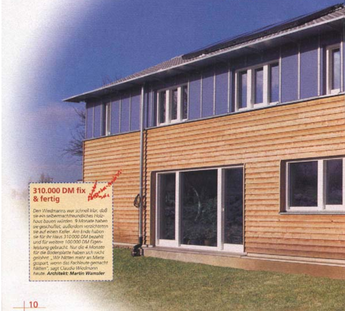
Für das Passivhaus mußten die Fenster supergut sein: Dreifachverglasung mit extrem aufgedoppelten Rahmen, K-Wert: 0,7 W/m 2 K.
