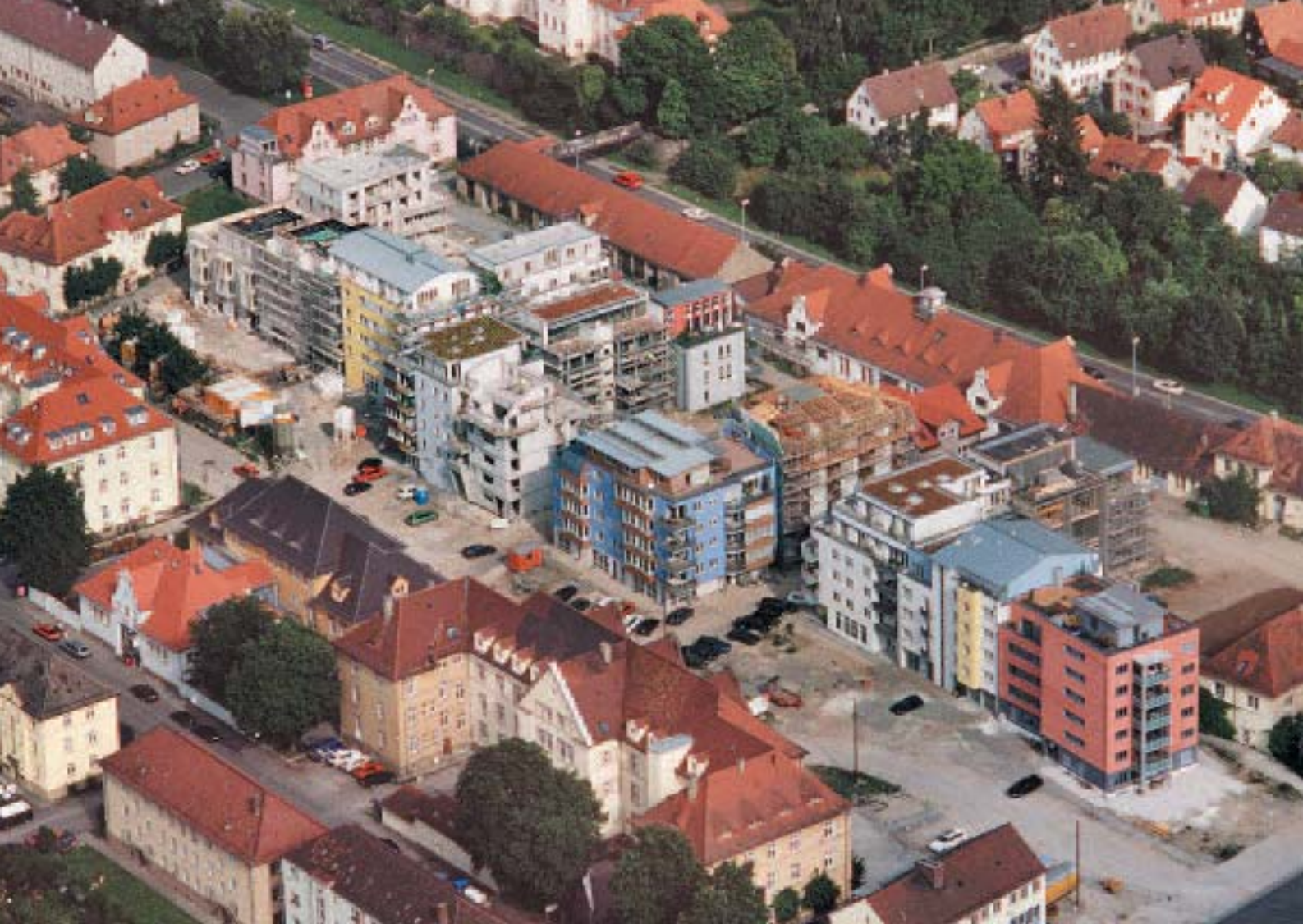
Baugruppe Süd (blaues Gebäude) im Loretto-Areal
