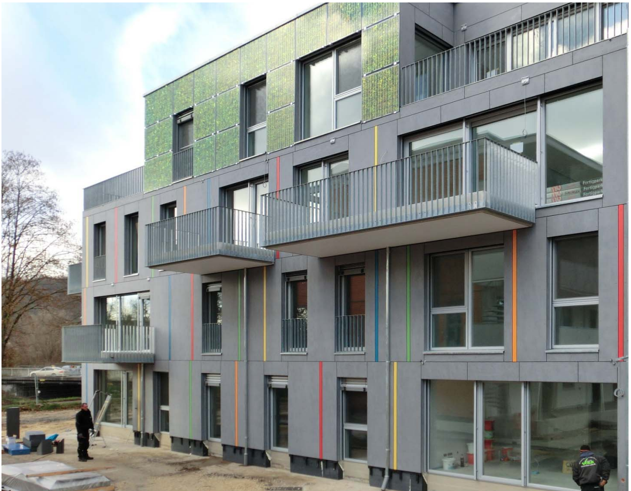
Südostansicht zum gemeinsamen Hof hin
