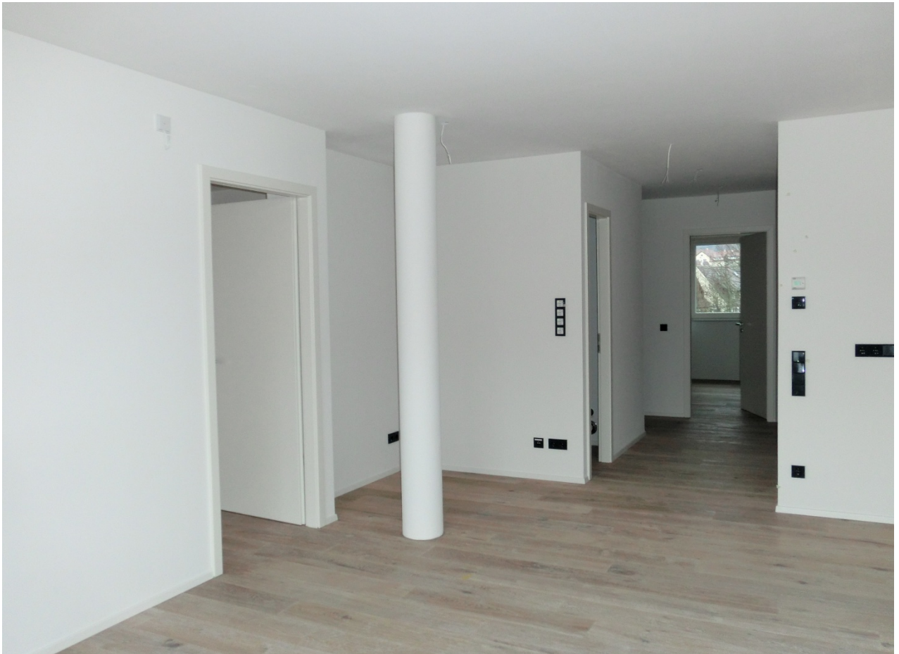
Wohnung 6 (2. OG) vom Wohnraum Richtung Flur, Schlafräume gesehen
