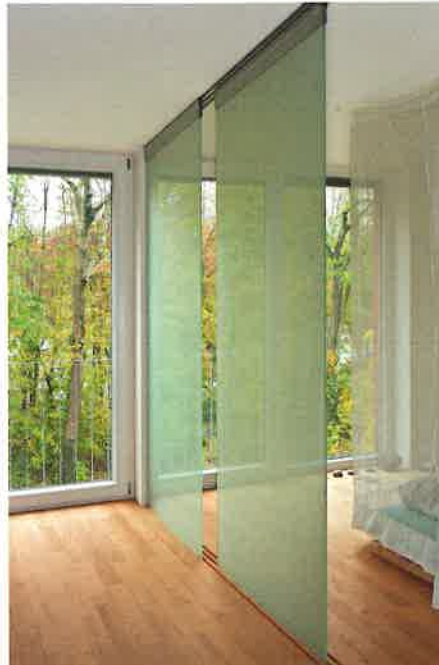
Mittels Glasschiebewänden ist der Schlafbereich zuschalt- oder abtrennbar.
